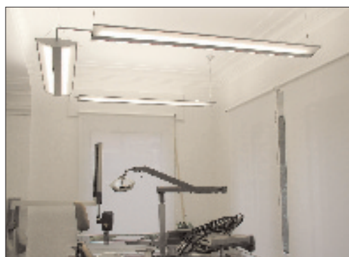
Zahnarztpraxis / Dental surgery 3 Modulleuchten in U-Form mit L-Verbindern 3 modular luminaires in a U-arrangement with L-connectors
